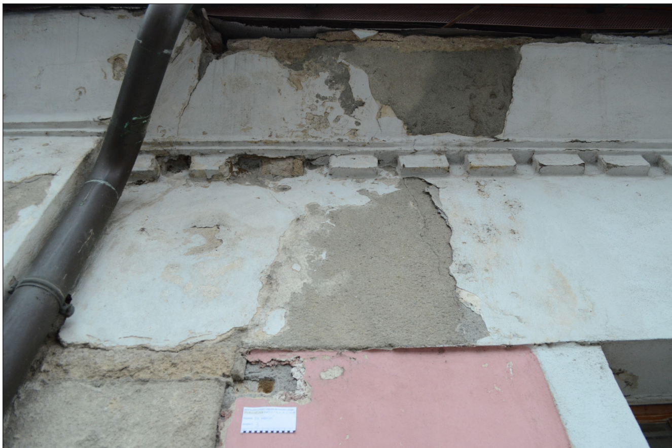
Obr. 11 - Degradace omítek kolem římsy a okapového svodu vlivem zatékání.
