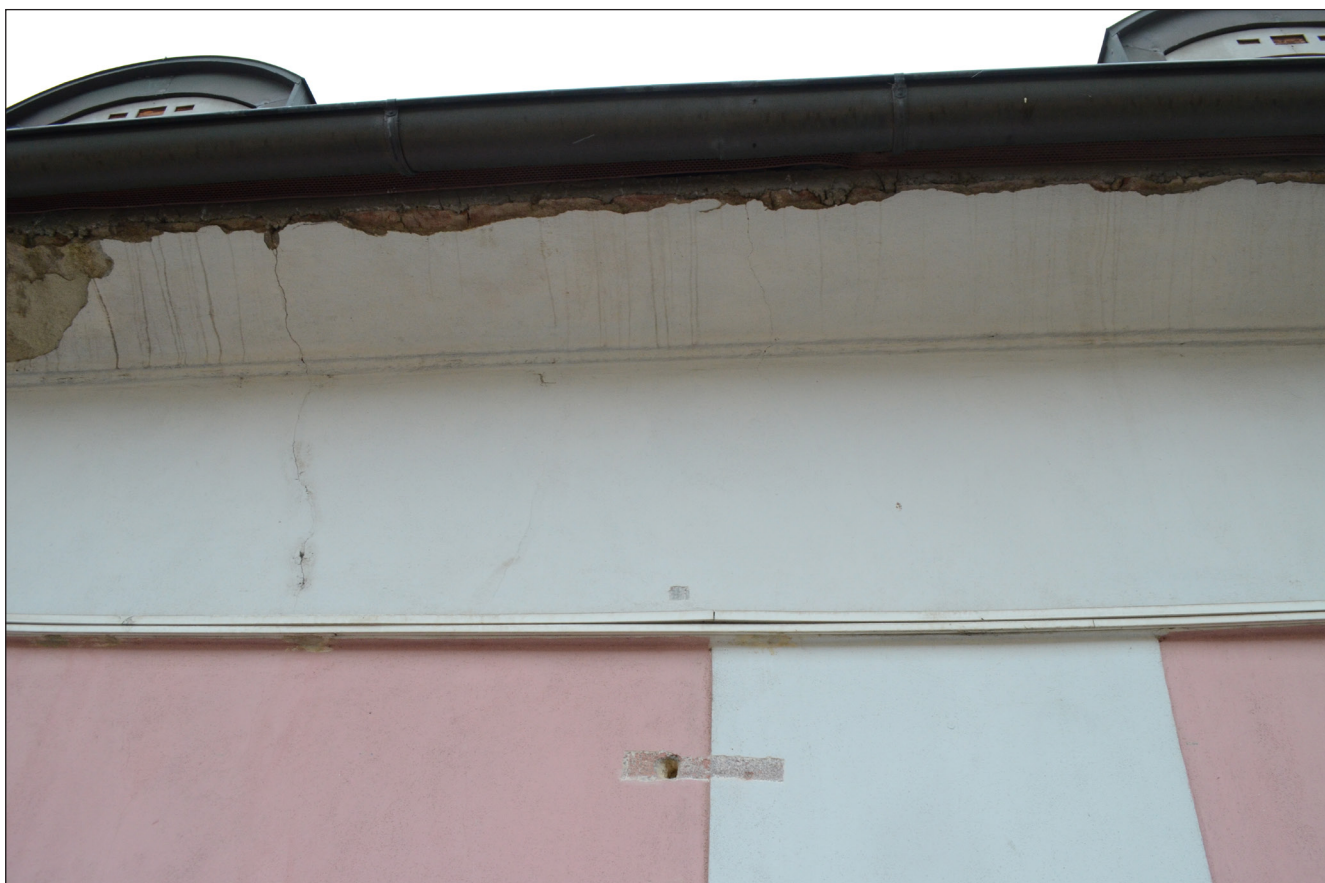
Obr. 12 - Omítky pod přesahem střechy jsou rozpraskané a částečně opadané.
