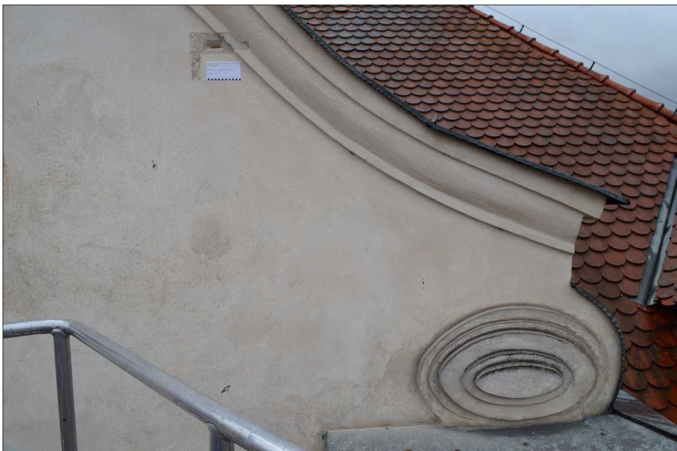
Obr. 10 - Pohled do štítu budovy a provedení stratigrafické sondy.
