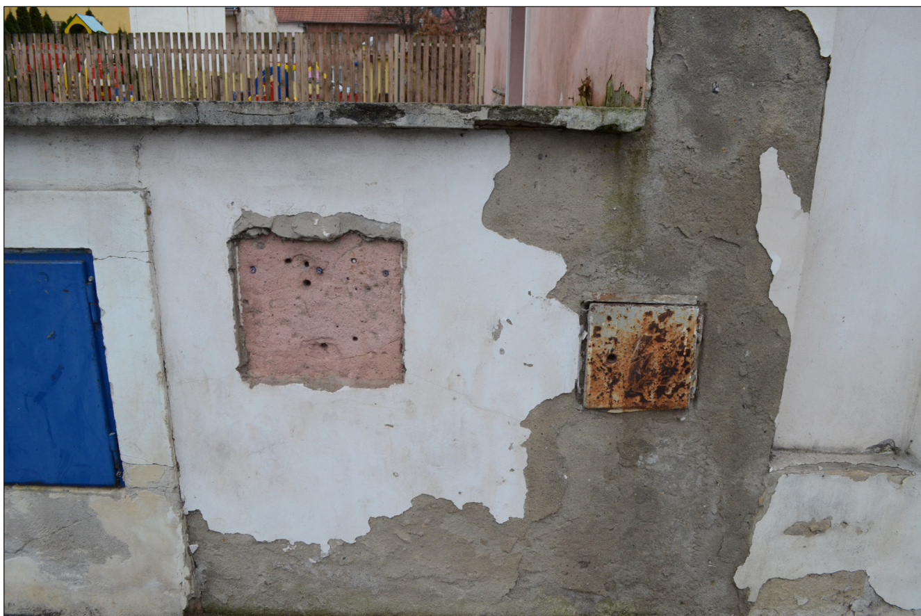
Obr. 13 - Stav omítek v přízemních partiích, zde docházelo k častějším opravám, z fáze konce 20. let pochází červená omítka pod tvrdou vápenocementovou nejmladší opravou.
