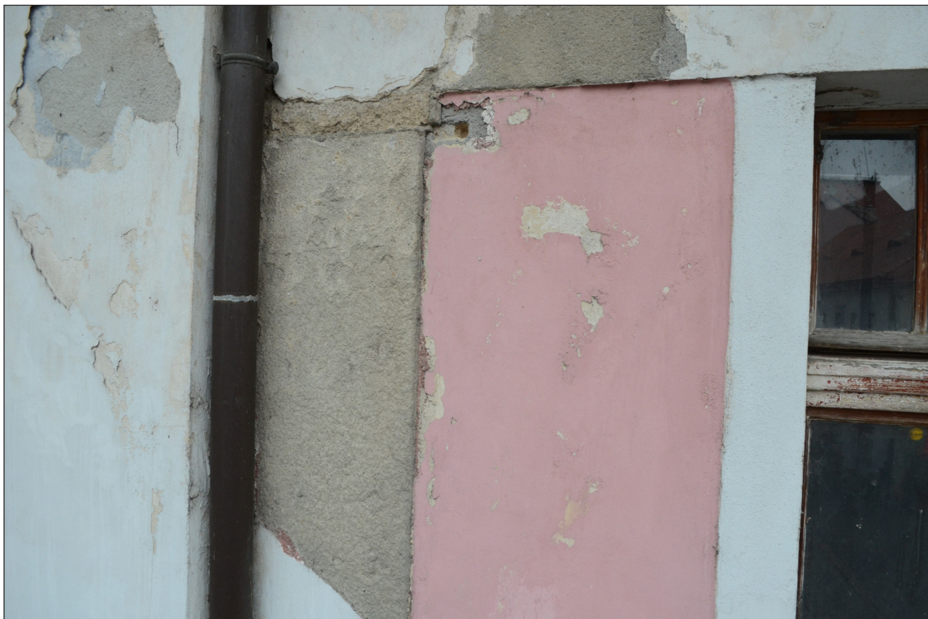
Obr. 7 - Detail degradace omítek u svodu okapu vlivem zatékání dešťové vody.
