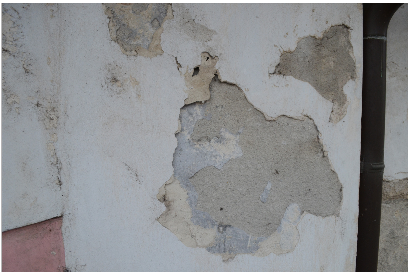
Obr. 8 - Detail degradovaných vrstev omítek odlučujících se od podkladu.
