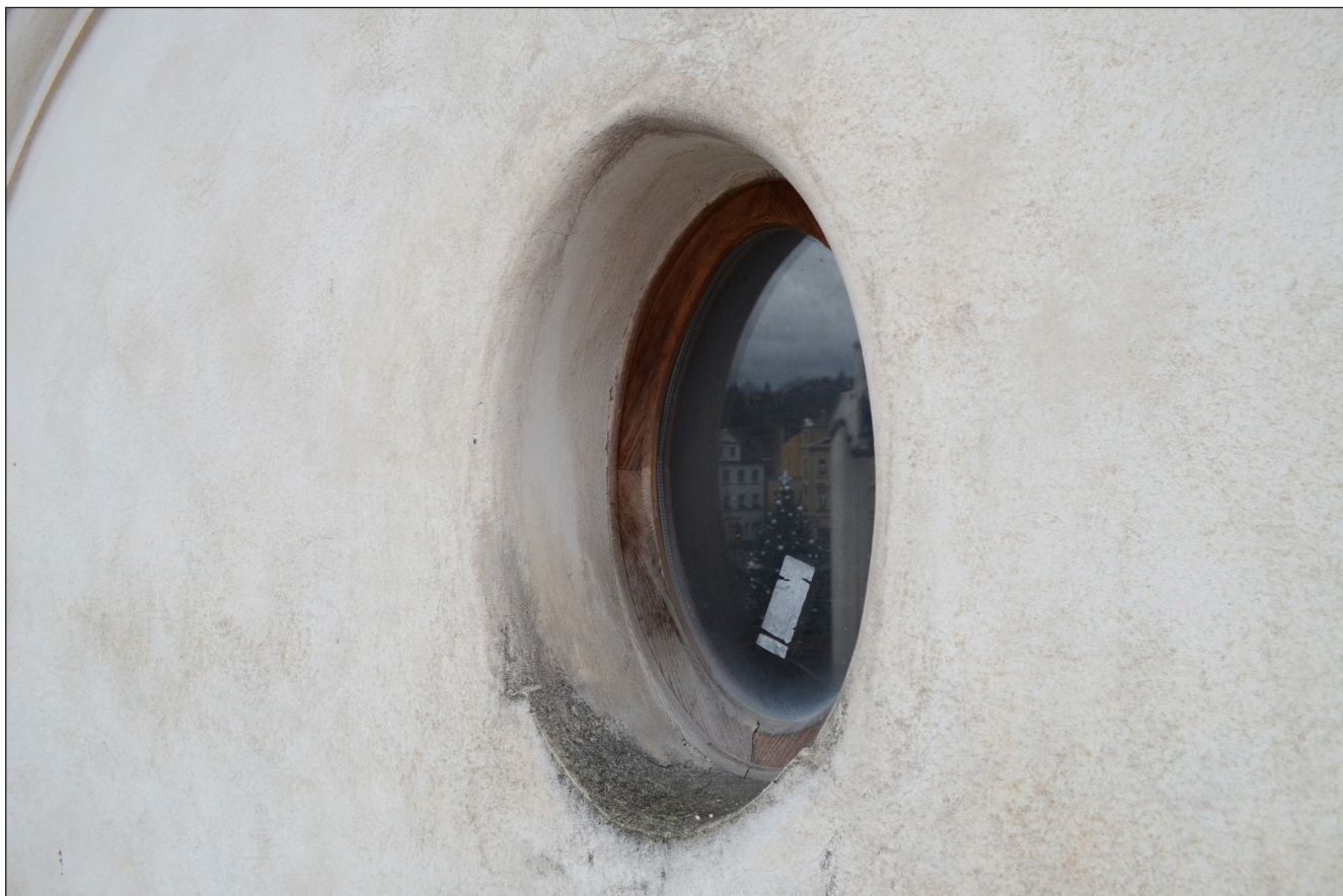
Obr. 9 - Okénko ve vrcholu štítu - všechny omítky štítu a střešních oken jsou nové, z poslední opravy provedené v roce 2002, zůstaly bez nátěru.
